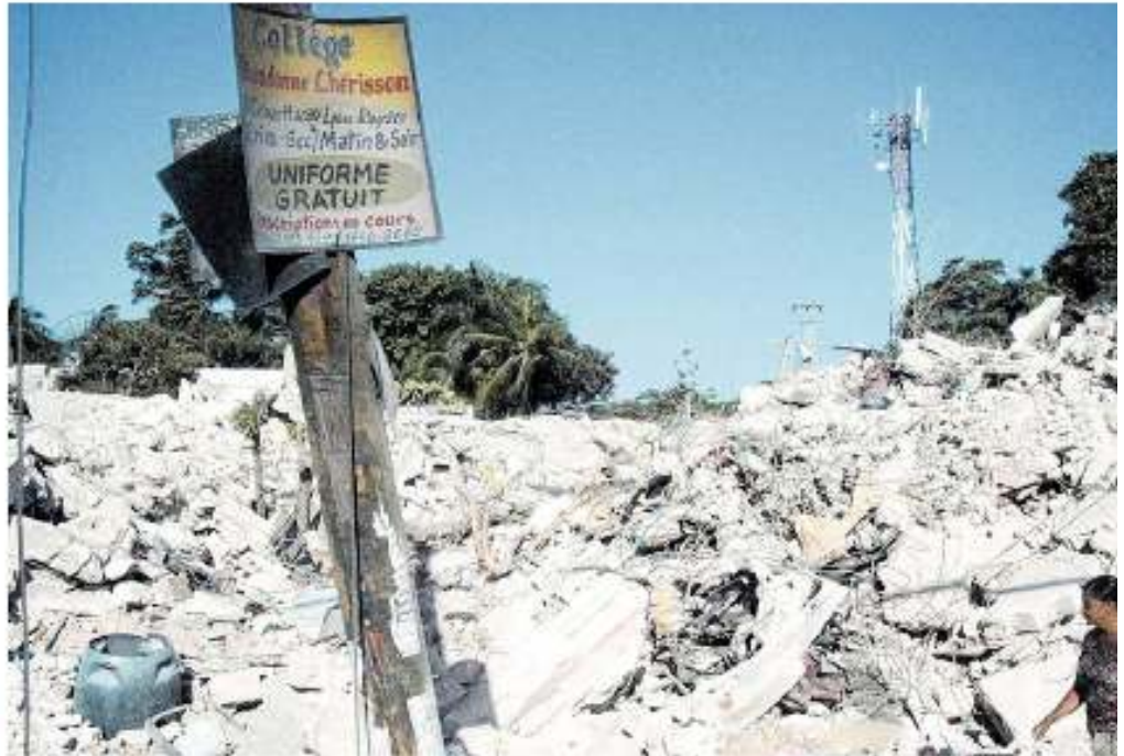
Schreckliche Bilder aus dem Katastrophengebiet nach dem Erdbeben: Wie viele Tote unter den Trümmern liegen, wird sich nie aufgeklärt werden. Der Wiederaufbau wird noch Jahrzehnte andauern.
